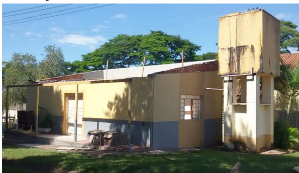
Bij de renovatie van de wasserij is het asbesthoudende dak vervangen (foto links). Op de foto rechts de nieuwe situatie. Binnen ligt een nieuwe keramieken vloer. Het naastgelegen waterbassin, met een capaciteit van 10.000 liter en geheel gevuld met eigen bronwater, is lekvrij gemaakt.
