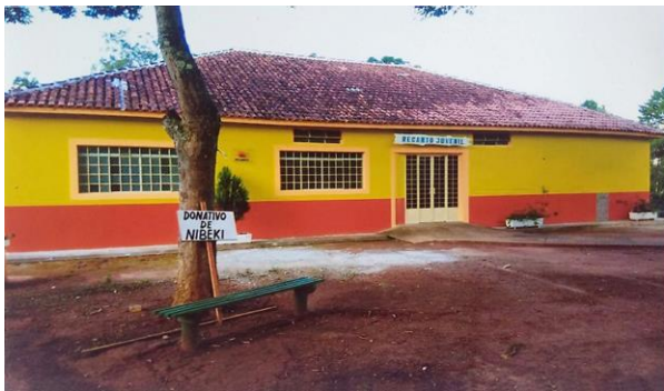
De gerenoveerde Recanto na het schilderwerk, met vernieuwde raamkozijnen en robuuste hoofdingang.
