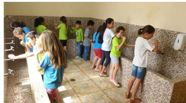
De nieuwe voorziening heeft 15 kranen; de muur is afwasbaar en de vloer heeft een antislip-coating.
