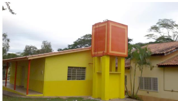
Bij de renovatie van de wasserij is het asbesthoudende dak vervangen (foto links). Op de foto rechts de nieuwe situatie. Binnen ligt een nieuwe keramieken vloer. Het naastgelegen waterbassin, met een capaciteit van 10.000 liter en geheel gevuld met eigen bronwater, is lekvrij gemaakt.
