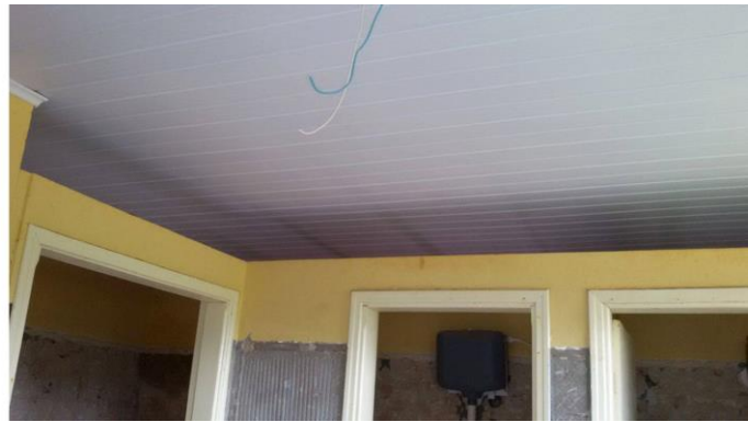
De nieuwe plafonds zijn van beter materiaal, met een hoge mate van duurzaamheid.
